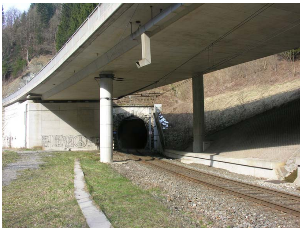
Ostportal Untersteintunnel I
